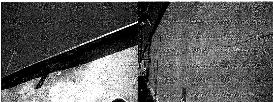
Fot.18,19 – uszkodzenia tynku na poziomie dachu budynku
