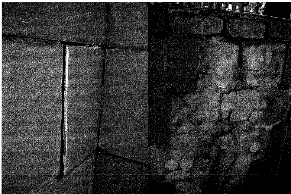
Fot. 21,22 – odspojone lub brak płytek okładzinowych ściennych
