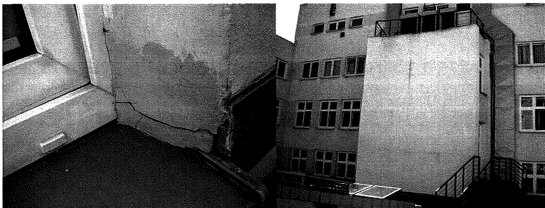
Fot.13, 14 – przebarwienia glifów od strony dziedzińca wewnętrznego <zdjęcie po lewo>, ściana frontowa klatki schodowej od strony dziedzińca wewnętrznego <zdjęcie po prawo>
