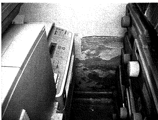
Fot. 11 – zawilgocone ściany magazynu wydziału informatyki
