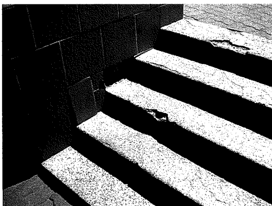
Fot.25 – zniszczona okładzina schodów zewnętrznych lastrykowych
