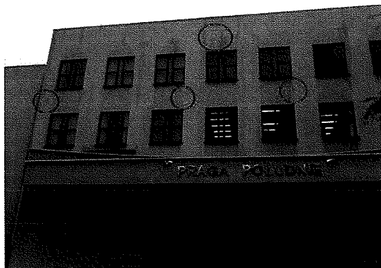
Fot. 26 – uszkodzenia tynku na elewacji od strony ulicy Grochowskiej
