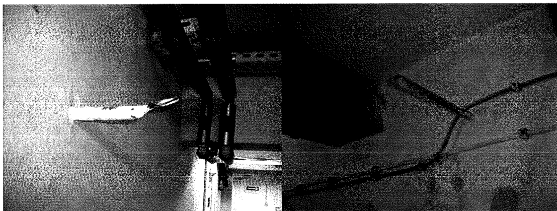
Fot. 7,8 – wystające ze ścian metalowe elementy
